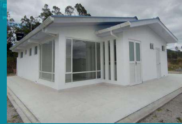
Puesto de salud en el corregimiento de Cuatis-Gualmatán
